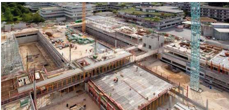
Baustelle der neuen Chirurgie, Oberer Eselsberg
