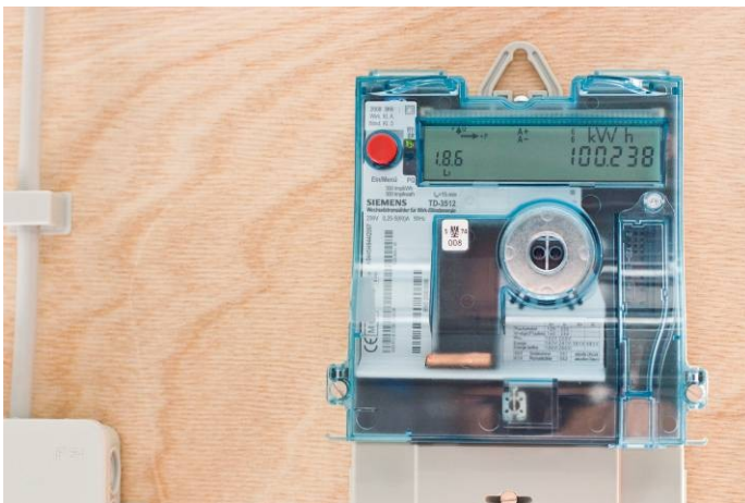
Anzeige Smart Meter beim Ladevorgang
