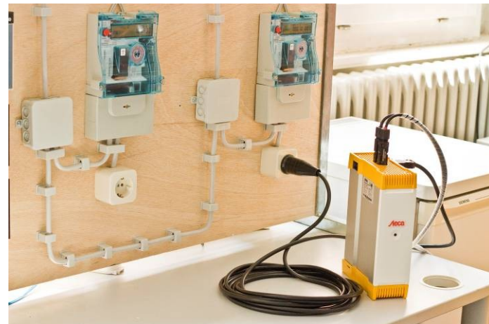
Smart Meter – Einspeisung ins Netz
