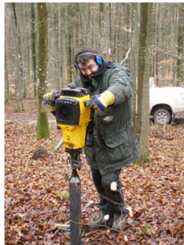
Probenahme mit dem Motorschlaghammer.
