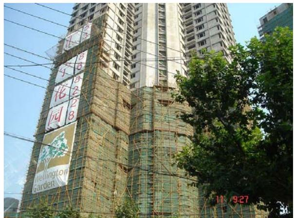
Abb.4 Bambusgerüst an einem Hochhaus – Quelle:
