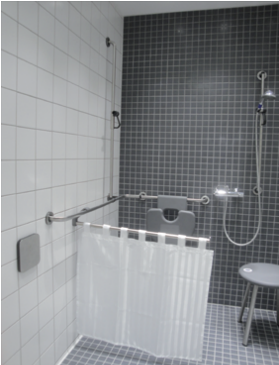
Flexible Vorrichtung zur Wandmontage unterschiedlicher Elemente, die bei Bedarf formschön abgedeckt werden kann
