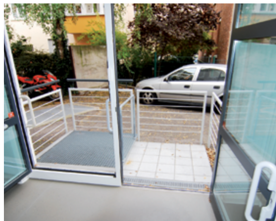
Niveaugleiches Austrittspodest und angeschlossene Hubplattform
