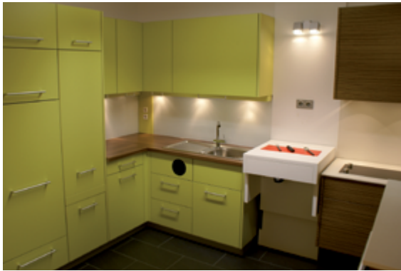
Beleuchtung unter Unterschränken
