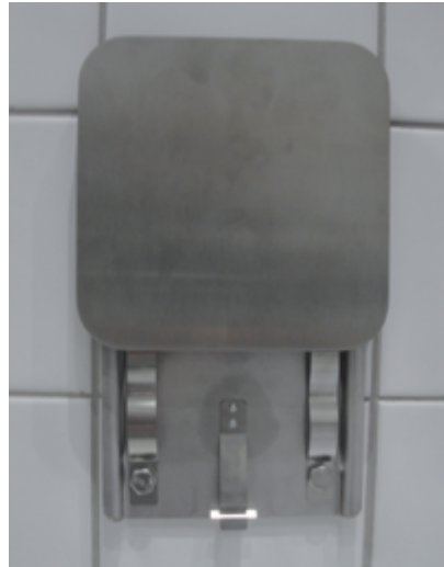
Flexible Vorrichtung zur Wandmontage unterschiedlicher Elemente, die bei Bedarf formschön abgedeckt werden kann
