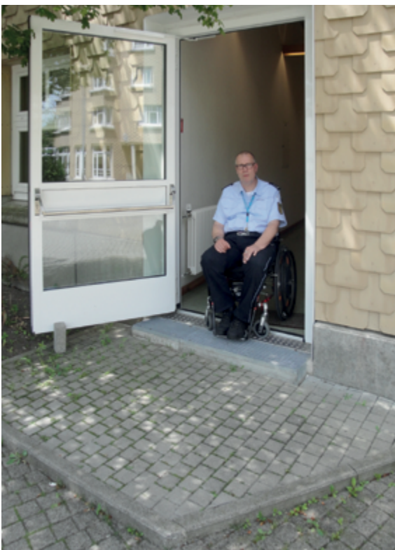
Niveaugleiches Austrittspodest und angeschlossene Hubplattform
