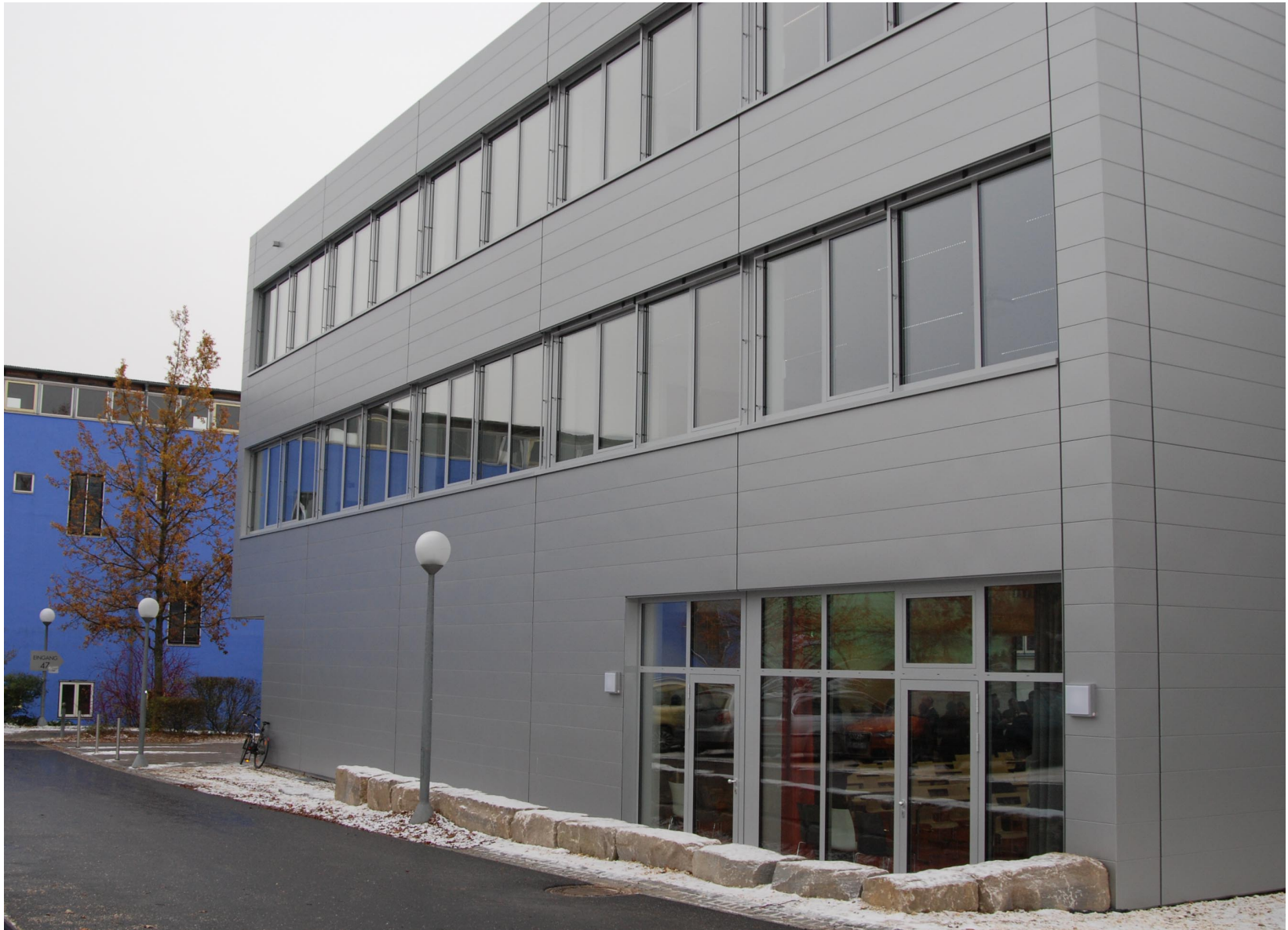
Frontansicht des Lehrgebäudes von der Albert-Einstein-Allee:
