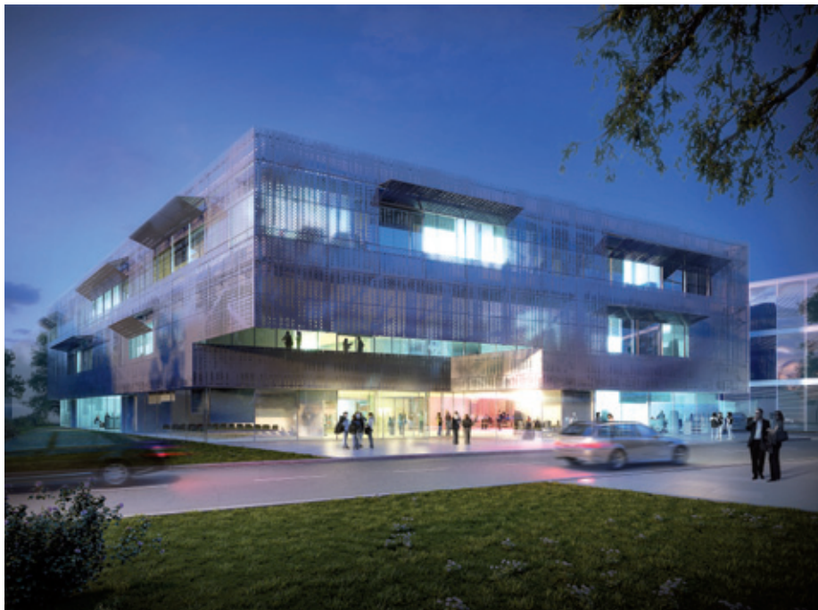
Fügt sich harmonisch in die Wissenschaftsstadt ein: So soll das Helmholtz-Institut Ulm für Elektrochemische Energiespeicherung aussehen
